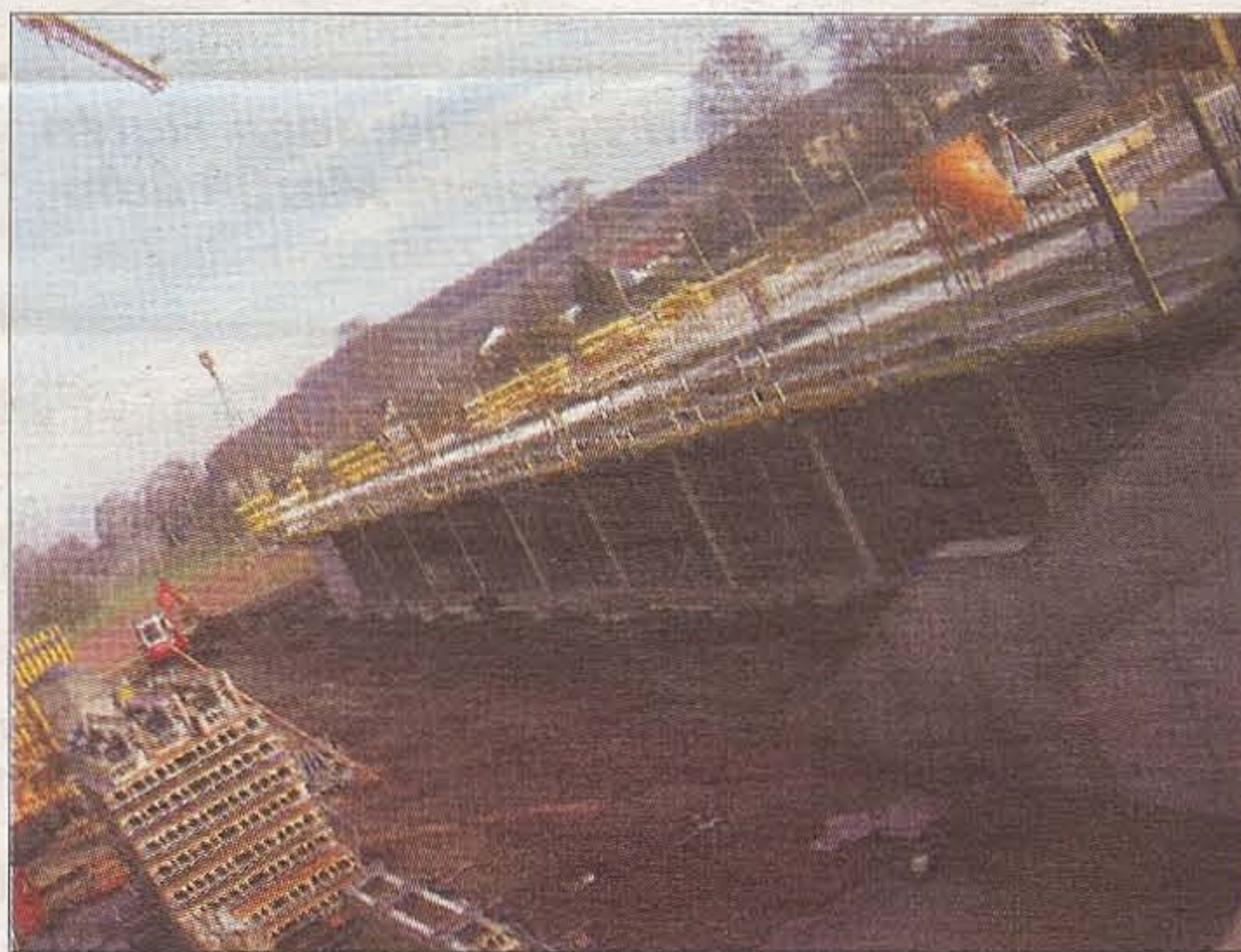
Le nouveau bâtiment en chantier.
