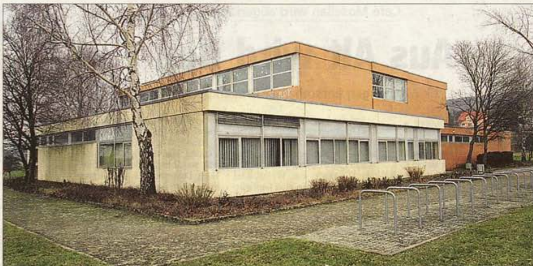
Das Lyzeum nutzt zunächst die Räumlichkeiten der alten Realschule, zur „Rentrée“ 2009 soll der Neubau fertig sein. (FOTO: GUY JALLAY)
