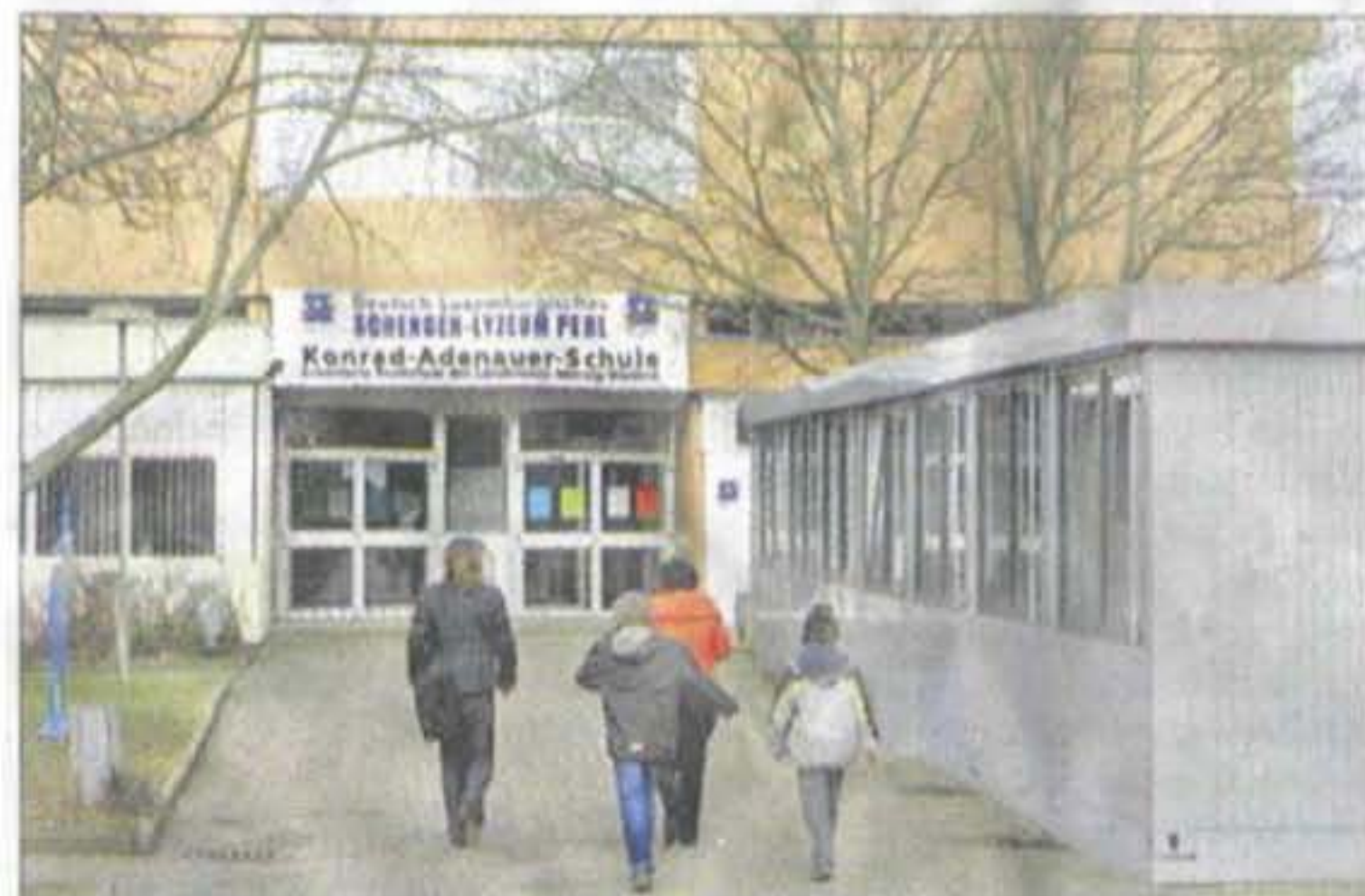
Zurzeit teilen sich das Schengen-Lyzeum und die auslaufende Realschule ein Gebäude. Rechts im Bild sind einige Schulcontainer zu sehen.
